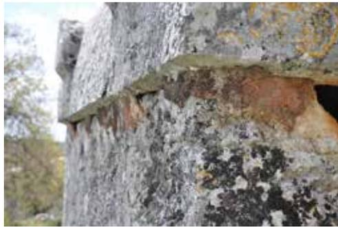
Abb. 103. Hyposorionsarkophag (HS2) die Reste von Mörtel mit rötlichen Ziegeleinschlüssen
