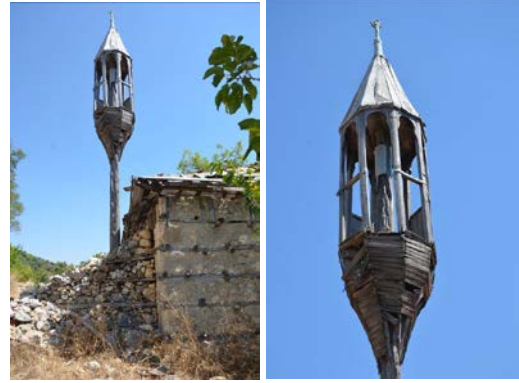
Fig. 22. Güçlü Köy Camisi Minaresi
